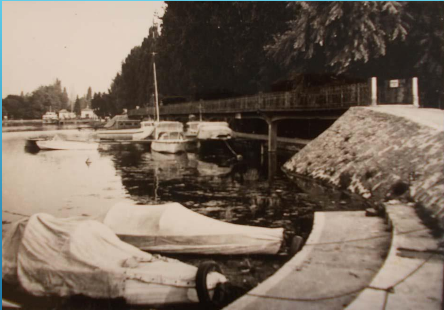
A ZIELINSKI-FÉLE VASBETON HÍD 1978
